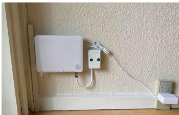
Et eksempel fra Fibia på boksens størrelse og placering ca. 20 cm. over gulvhøjde
